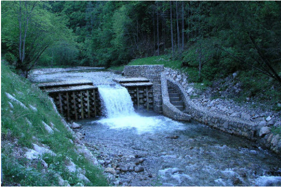
Slika 3-4: Deželni jez na Kokri z ribjo stezo v bližini naselja Spodnje Jezersko leta 2008 (Avtor fotografije: A. Bizjak) in drstišče pod HE Mavčiče leta 2005 (Avtor fotografije: M. Povž)
