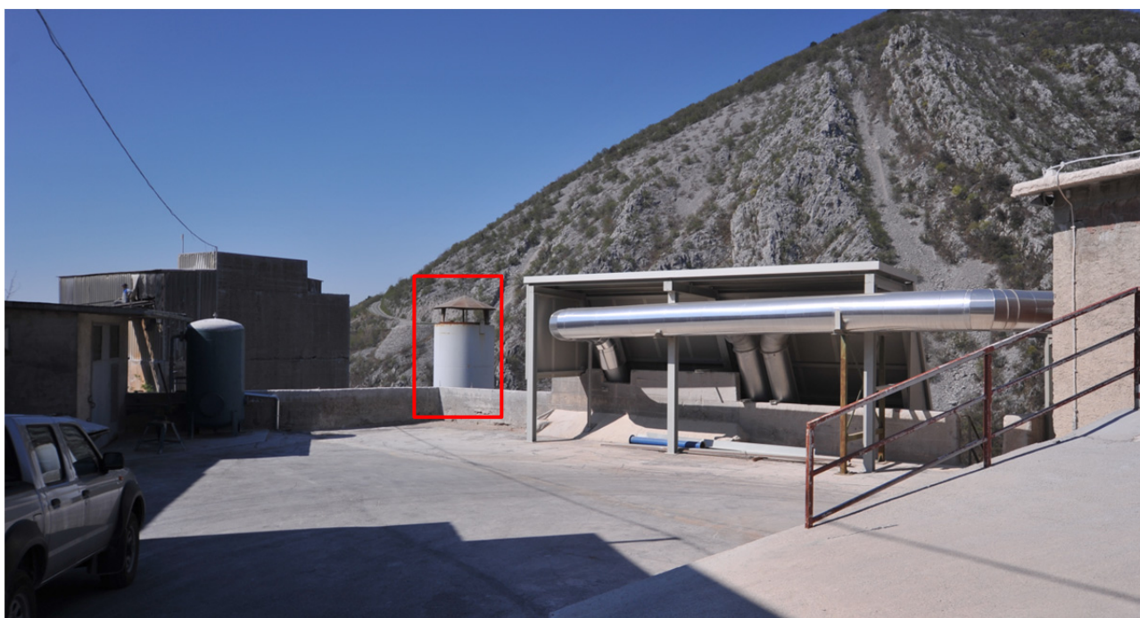
Slika 18: Dimnik v apnarni, slikano z zgornje ploščadi
