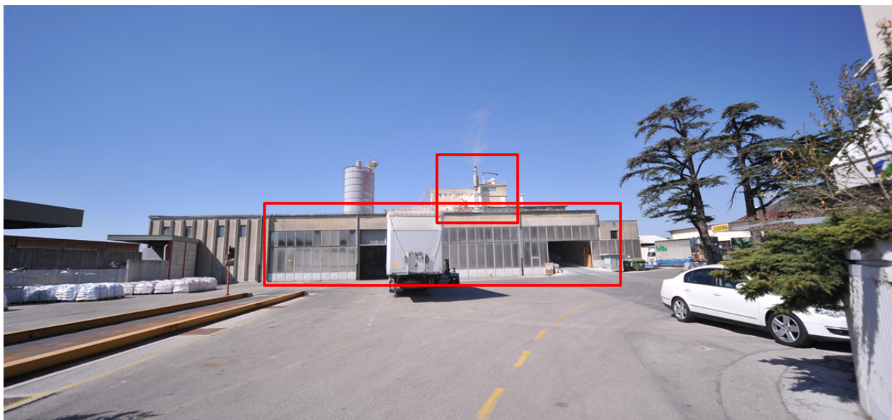
Slika 20: Hidrarna na Cesti IX. korpusa, pogled na V fasao in izpust na strehi
